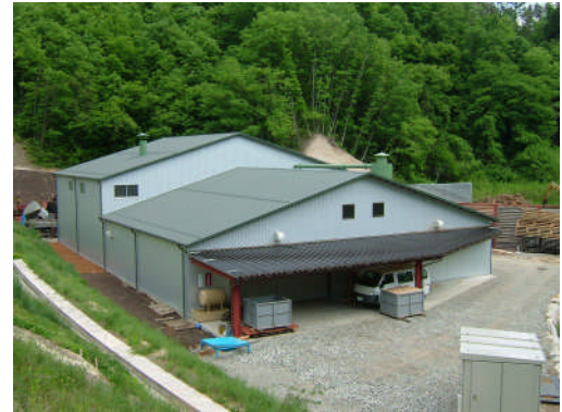
飯田市内のペレット工場
